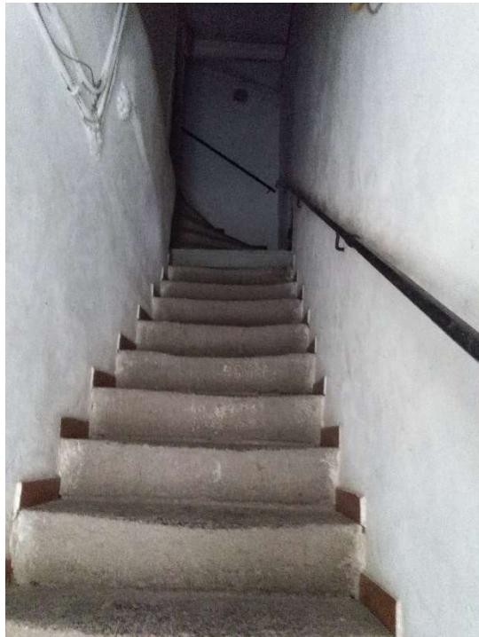
FOTO 8 zona notte Scale d'ingresso civico 71
